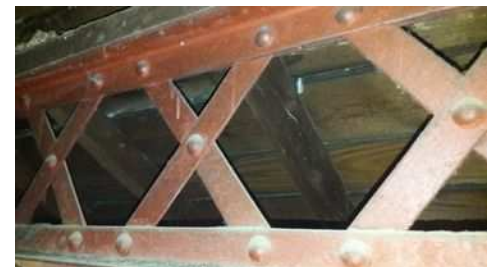
Charpente en rivets à frapper
