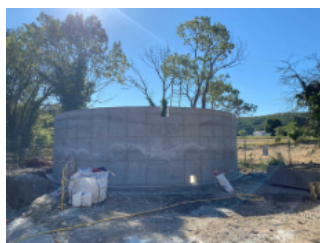
Agrandissement de la station d'épuration de Charols
